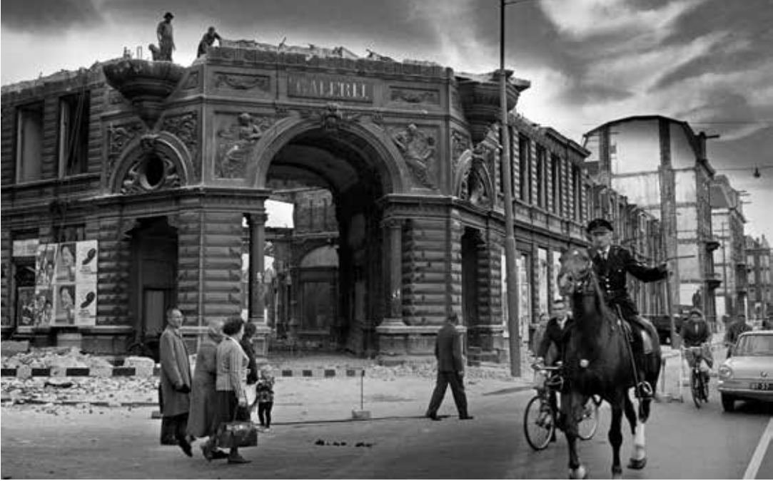
Demolition of the Galerij on Frederiksplein, former site of the Paleis voor Volkslijft , now De Nederlandsche bank , Amsterdam, 1961 © Ed van der Elsken / Nederlands Fotomuseum
